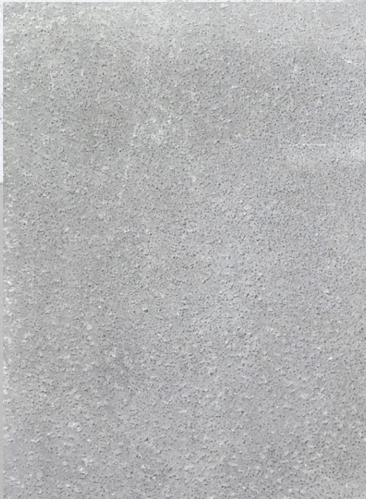
gładkie płyty - małe kawerny
